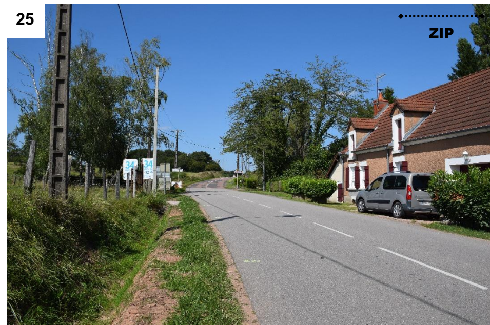
Figure 51 : Sortie nord de la Machine (source : ATER Environnement, 2021)
